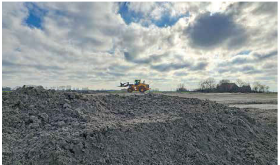
▲ Shovel op de bouwplaats
