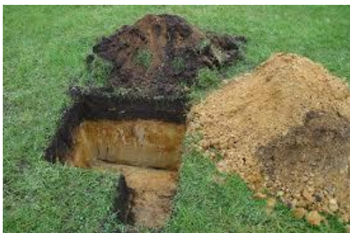
Afbeelding 14 Voorbeeld afgraving voor wandonderzoek.
